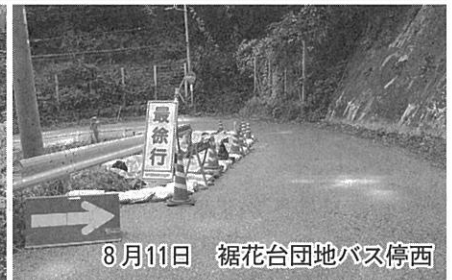
豪雨災害 県道小川長野線路肩崩落
