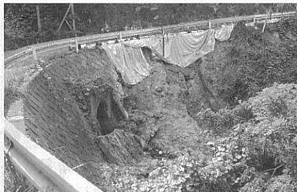
豪雨災害 県道小川長野線路肩崩落
