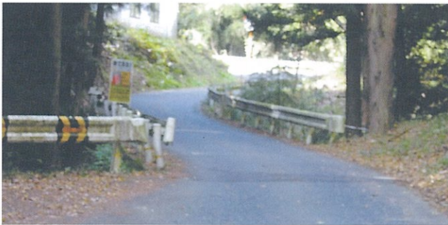
県道入山小市線 深沢地区
