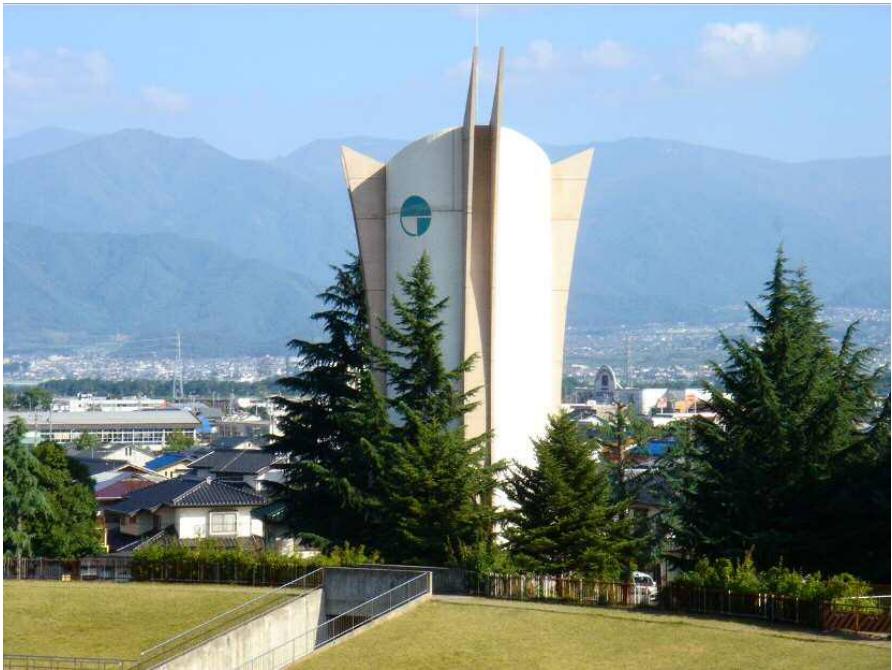
長野運動公園緊急貯水槽
