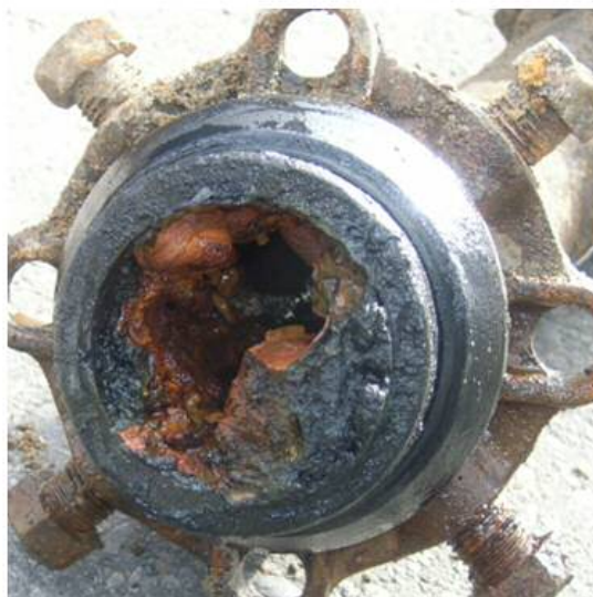
鑄鉄管 口径 75mm（昭和 42 年布設）
