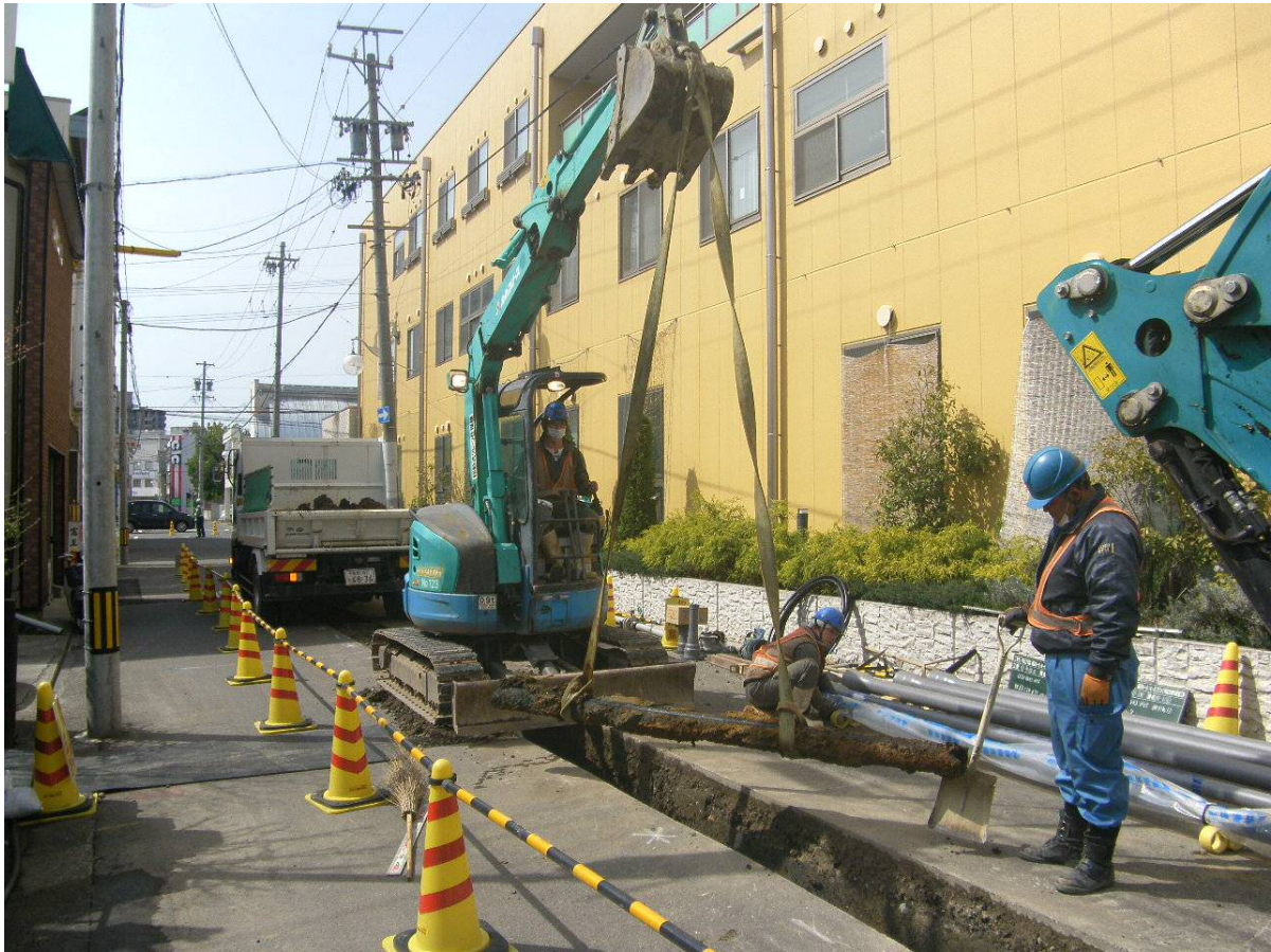
老朽管の更新（耐用年数を超過した既設管の撤去状況）
