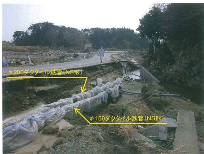
津波による道路崩壊における管路の挙動(宮城県東松島市内) φ 200(上水)、φ 150(下水) ダクタイトイル鉄管(NS形) : 被害なし
