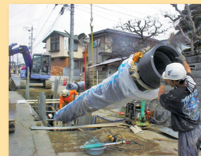
▲老朽管更新工事
