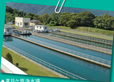
▲夏目ヶ原浄水場
