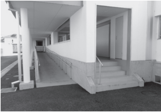
全面改善工事によりバリアフリー化を進めている市営住宅返目団地
