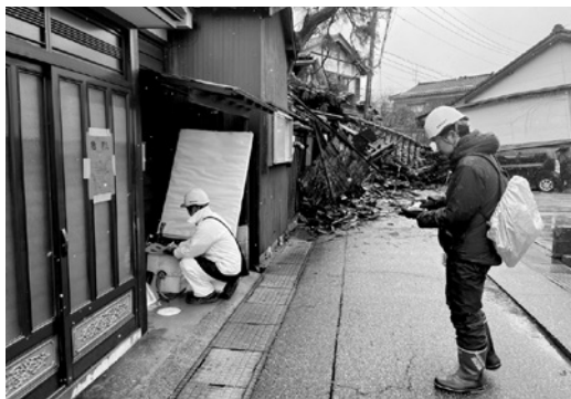
建築物が倒壊すると救助作業や復旧活動に支障が生じる
