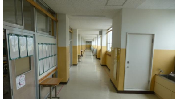
位置: 北校舎 廊下 撮影日: 平成30年8月6日
