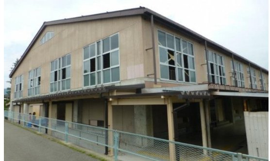
位置: 体育館 外観 撮影日: 平成30年8月6日
