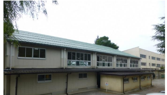
位置: 体育館 外観 撮影日: 平成30年8月6日
