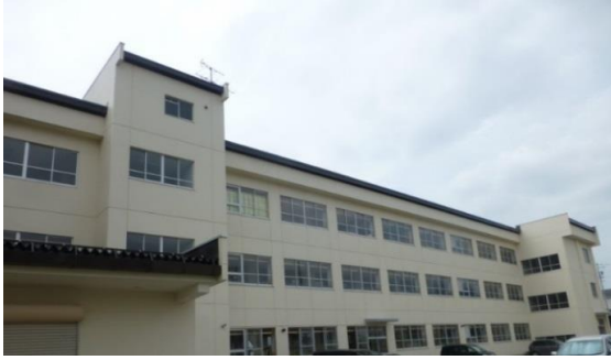
位置: 北校舎 外観 撮影日: 平成年8月6日
