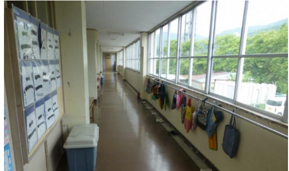
位置: 北校舎 廊下 撮影日: 平成30年8月6日
