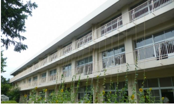
位置: 北校舎 外観 撮影日: 平成30年8月6日
