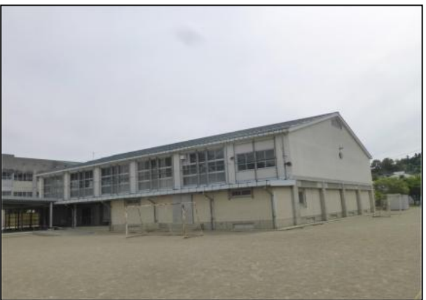
第二体育館外観
