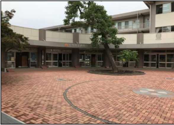
昇降口棟 外観
