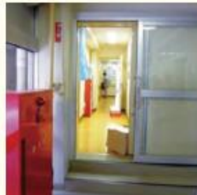
保育所部分は床を上げて水回りを 整備。避難時に使える扉も設置
