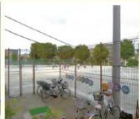
中学校校庭との境界に 防球ネットを整備
