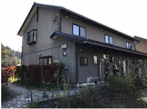
A棟北側外観
