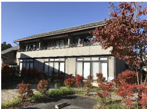
A棟南側外観
