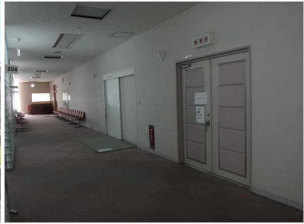
信州新町支所 3階 株式会社インフォメーション・ネットワーク・コミュニティ ヘッドエンド室入口
