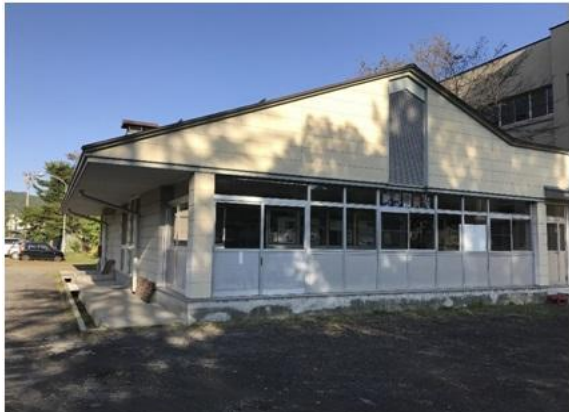
旧コンテナ室棟 全景
