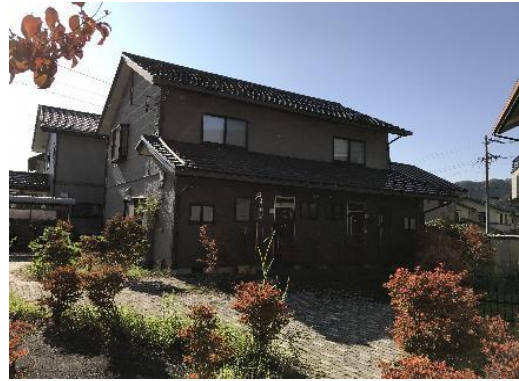
B棟北側外観
