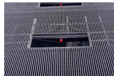
非常用進入口
