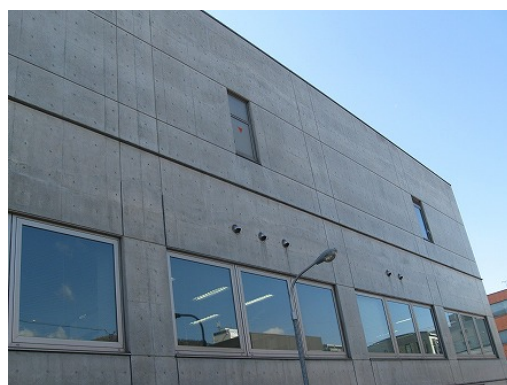
コンクリート打放し（素地）
