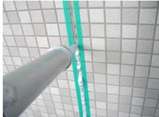
シーリング 施工状況
