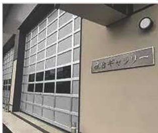
写真左／ギャラリー・外観 下左／西後町 下右／新田町の屋台
