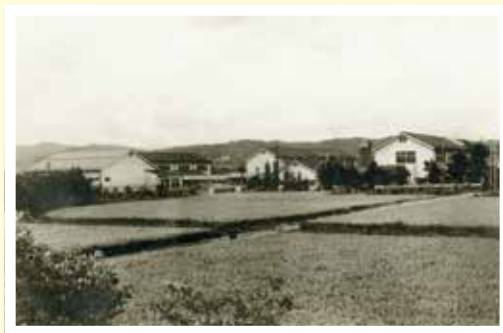
昭和38年校舎（右奥が長安橋）
