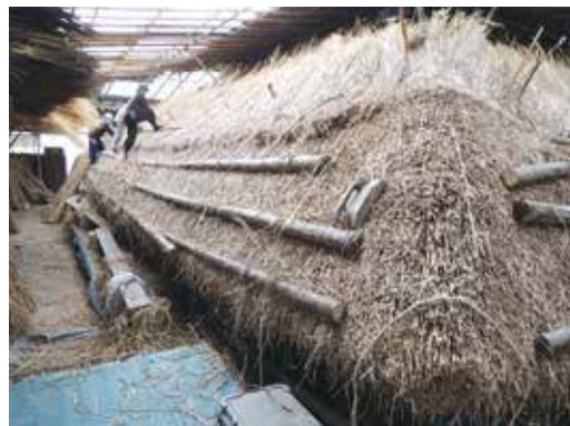
茅葺屋根の修理の様子
