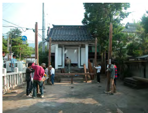
仮拝殿の組立作業
