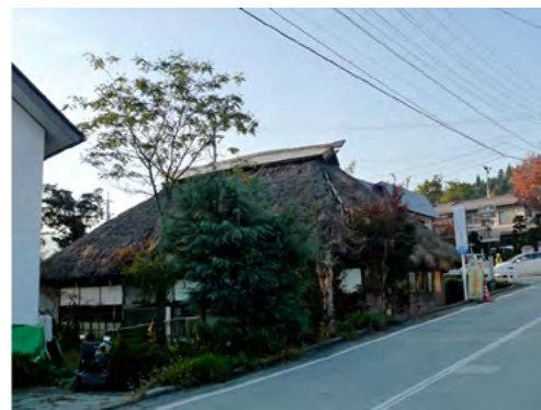
原山家住宅旧主屋（明治初期以前）
