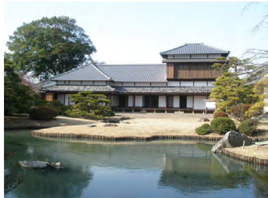
新御殿跡(真田邸：元治元年(1864))
