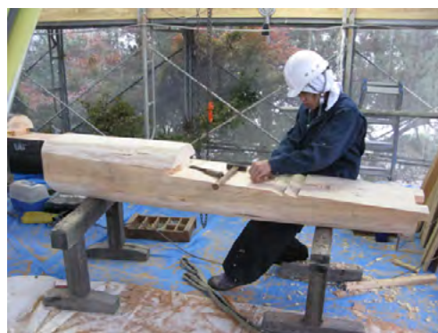
旧松代藩鐘樓の修理
