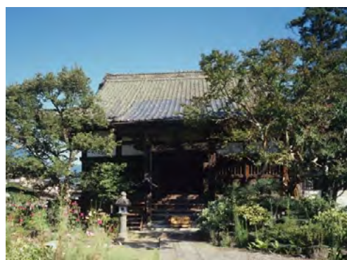
劣化の進む大英寺本堂（長野県宝）
