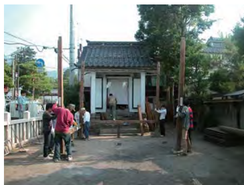
仮拝殿の組立作業
