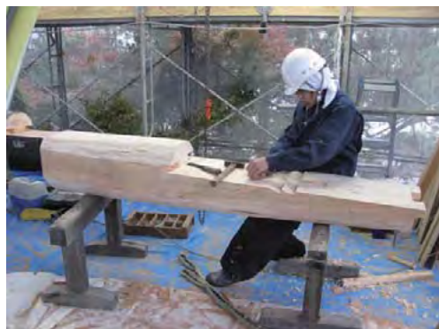
旧松代藩鐘樓の修理
