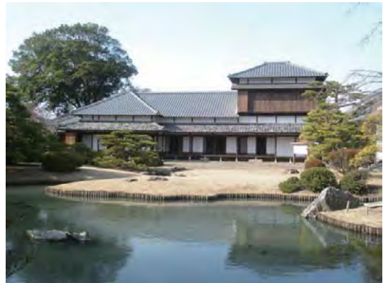
新御殿跡（真田邸：元治元年（1864））
