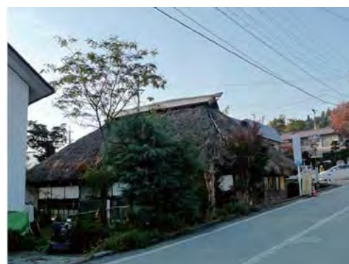
原山家住宅旧主屋（明治初期以前）
