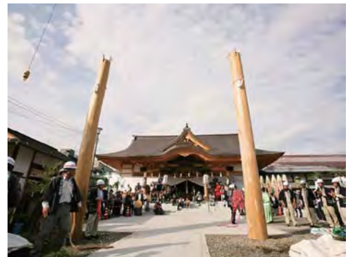
建御柱の完了
