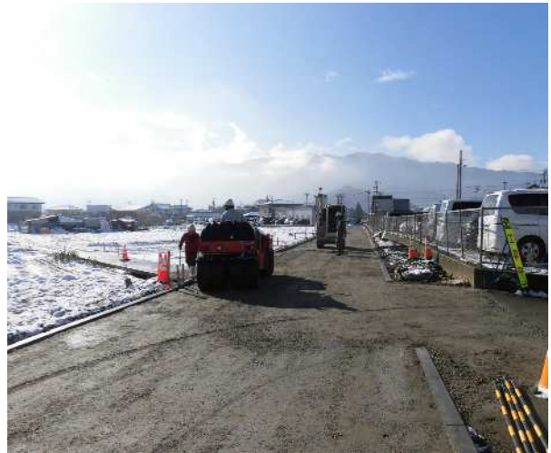
令和3年12月現在 施工状況
