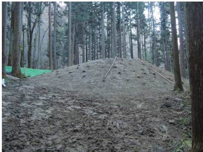
写真1 186号墳保存修理工事実施状況
