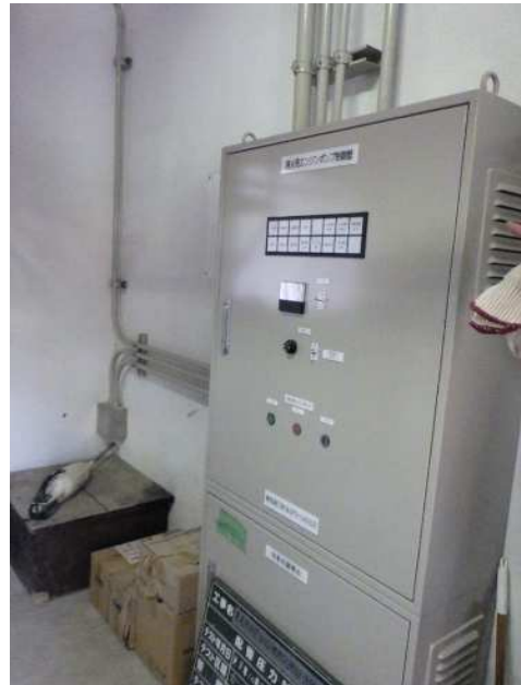
防災施設整備の実施状況 (消火栓エンジンポンプ制御盤の設置)
