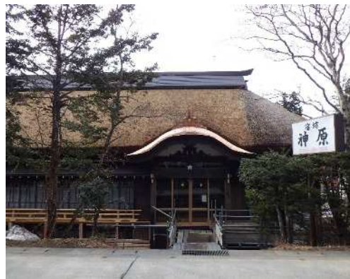
重伝建(戸隠地区)の保存修理状況
