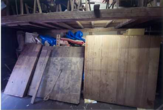
令和3年度 補修前(桜枝町)
