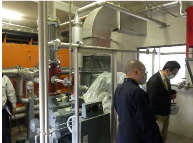
防災施設整備の実施状況 (消火栓エンジンポンプの更新)
