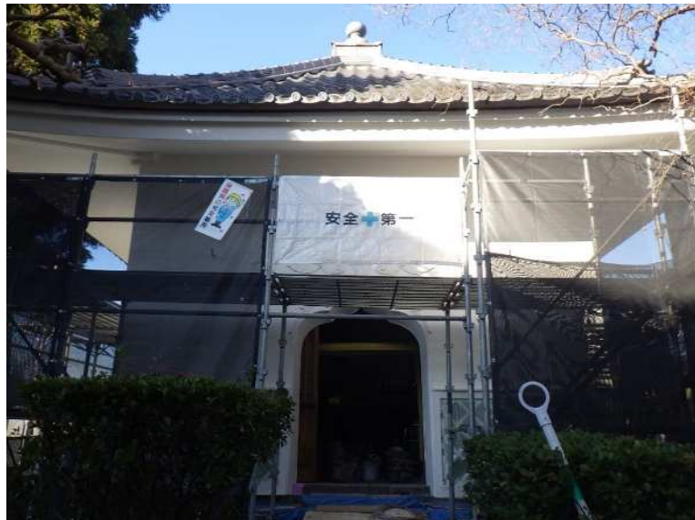
経蔵修理工事状況
