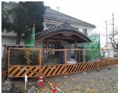
旧作新学校本館の修理状況
