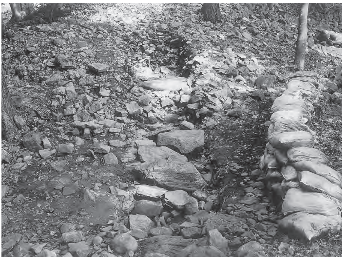
241 号墳Fトレンチ（西から）
