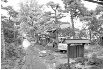
長沼の寺院の被災状況
