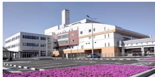
ちくま環境エネルギーセンター
