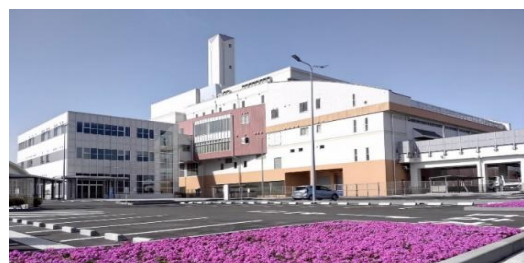
ちくま環境エネルギーセンター
