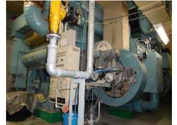
撤去困難な機械設備
