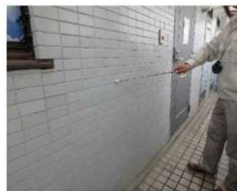
「外部（外壁）」調査の様子
