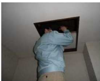
「小屋組・梁」調査の様子
