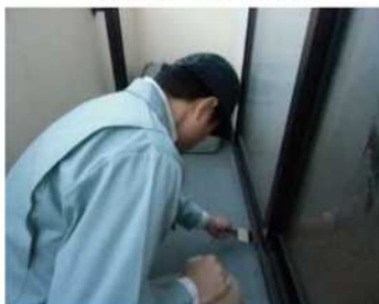
「外部（バルコニー）」調査の様子
