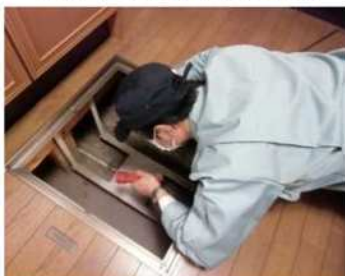
「土台・床組、基礎」調査の様子
