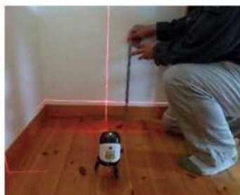
「床の傾きを計測する」調査機器
