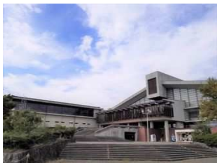
長野運動公園総合体育館（建替予定）
