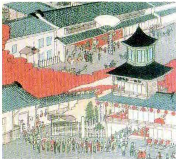
長野駅開業時の長野停車場(左側の平屋) (扇屋引札の一部/長野市立博物館/明治時代中期)
