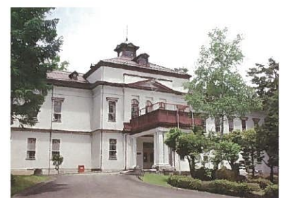
旧長野県庁舎
