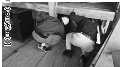
【工事前の現場調査（5月14日）】
