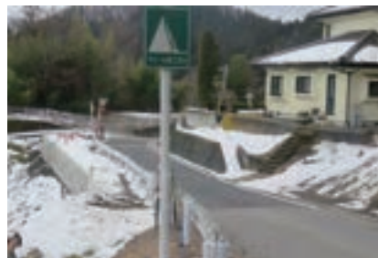
【工事完了（2024年1月）】
