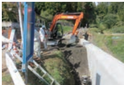
【復旧工事の様子（2023年10月）】
