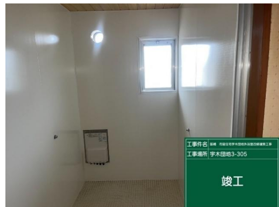
写真：浴室改修工事 竣工
