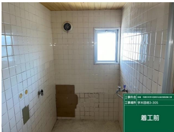
写真：浴室改修工事 着工前
