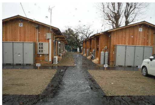
写真：若槻応急仮設住宅（木造タイプ）
