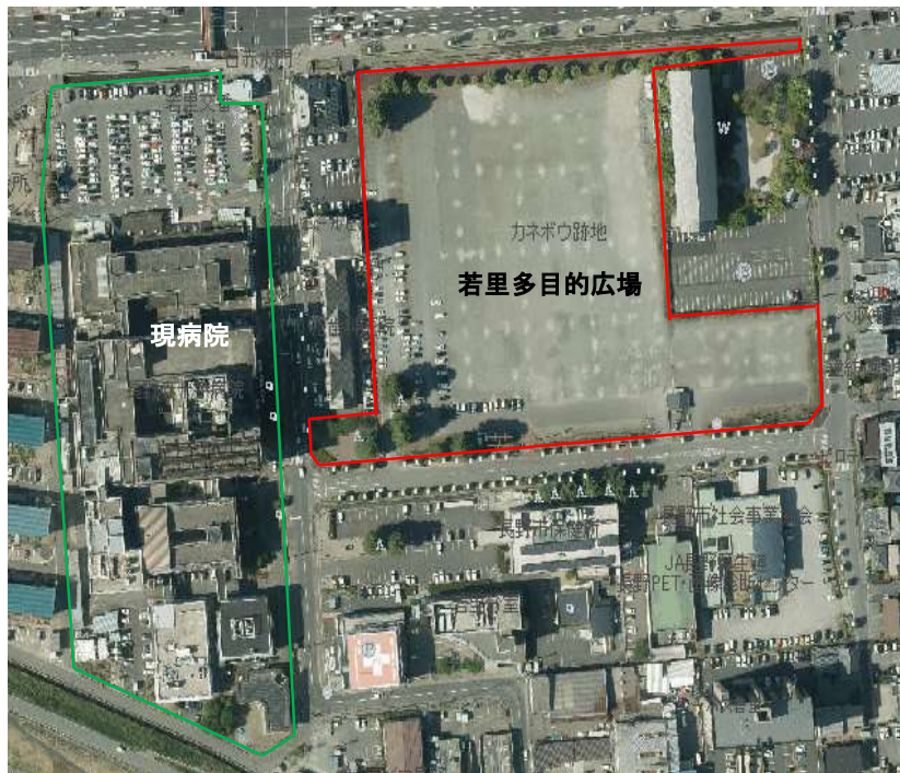
＜建設予定地の現況＞
