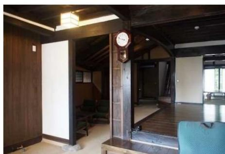
荒壁パネルによる補強壁の例
