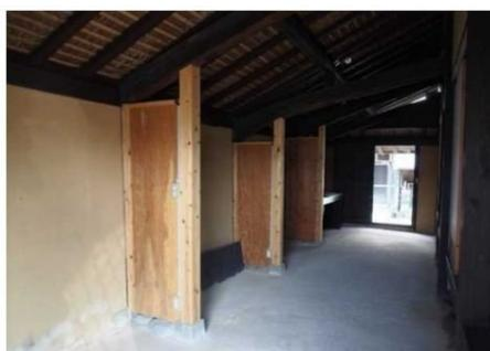
構造用合板による補強壁の例
