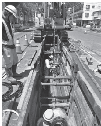
老朽管解消事業の進捗は
