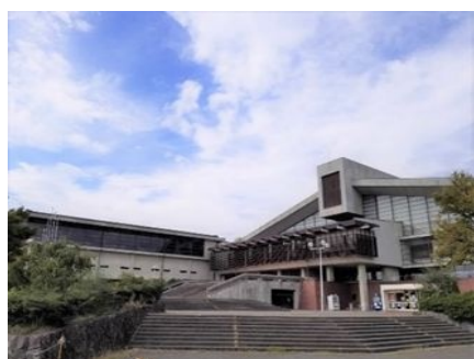
長野運動公園総合体育館（建替予定）
