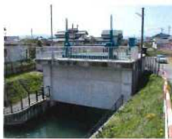
下堰サイホン出口
