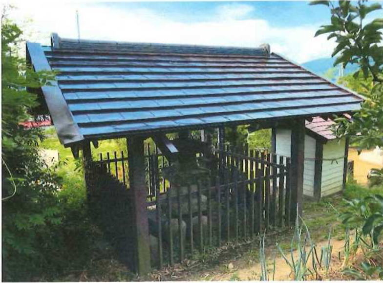
石造多層塔保護建物全景北面 施工後
