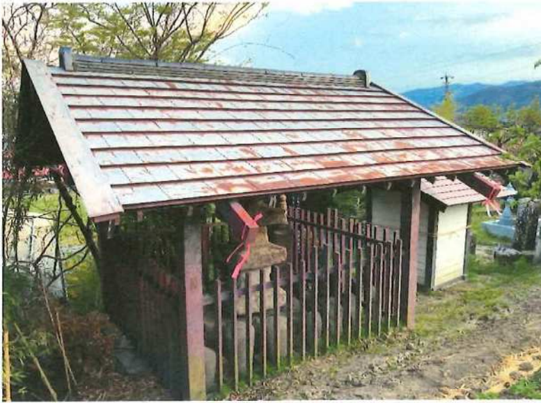
方田石造多層塔保護建物全景 施工前
