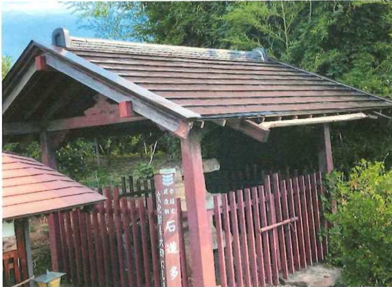
今回再塗装による修理を 実施した屋根南面 施工後
