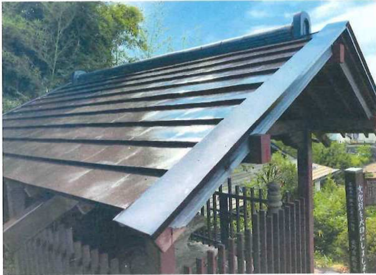
今回再塗装による修理を 実施した屋根の状態北面 施工後
