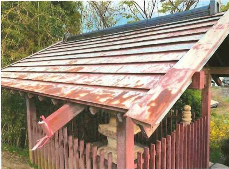
今回再塗装による修理を 予定する屋根の状態 1 施工前
