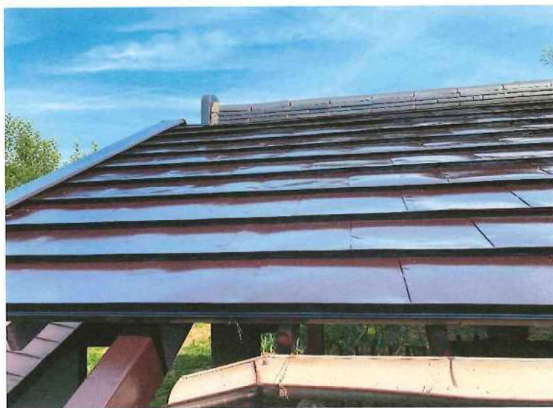
南面屋根の状態 施工後
