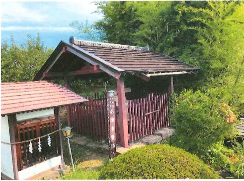
石造多層塔保護建物全景南面 施工後
