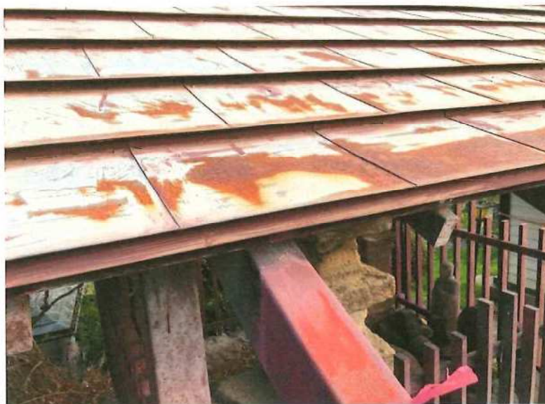
屋根の状態 2 施工前
