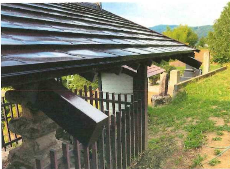
北面屋根の状態 施工後
