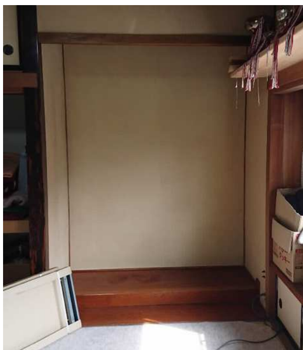
書類保管庫 施工前
