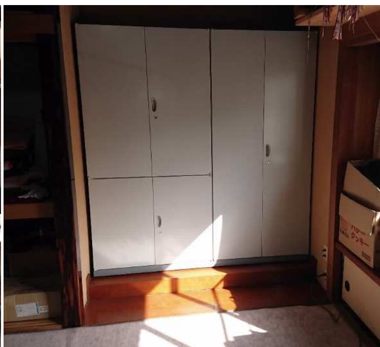
書類保管庫施工後
