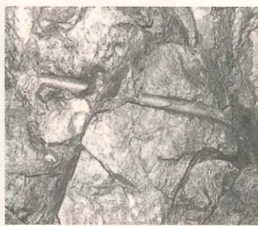
岩に残る削岩用ロッド跡
