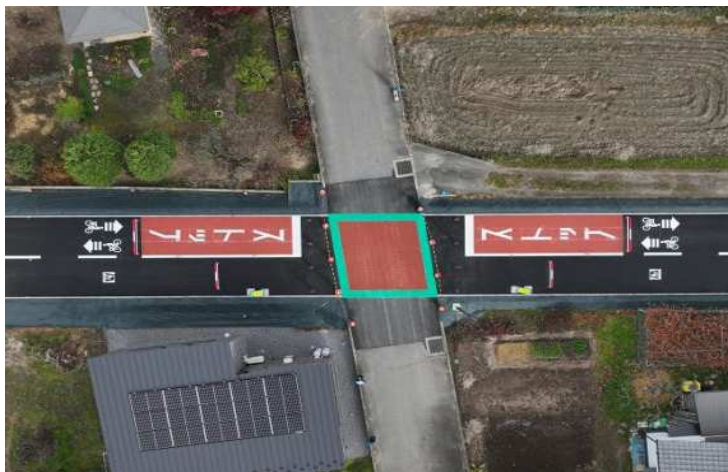
自転車道・遊歩道道路築造工事 整備箇所(町川田工区)
