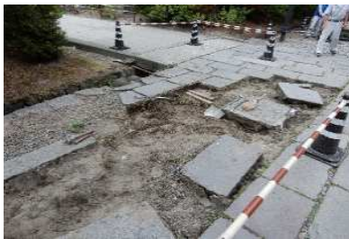
敷石更新作業状況
