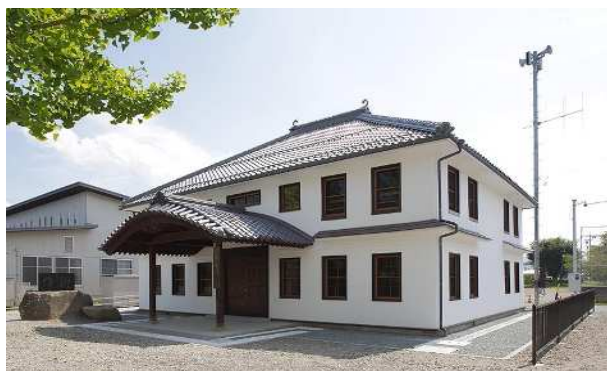
旧作新学校本館保存修理 (R7完了)
