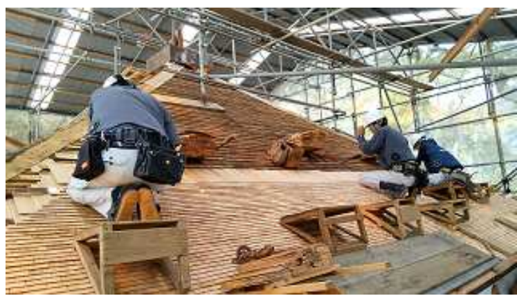
県宝真田信弘霊屋保存修理
