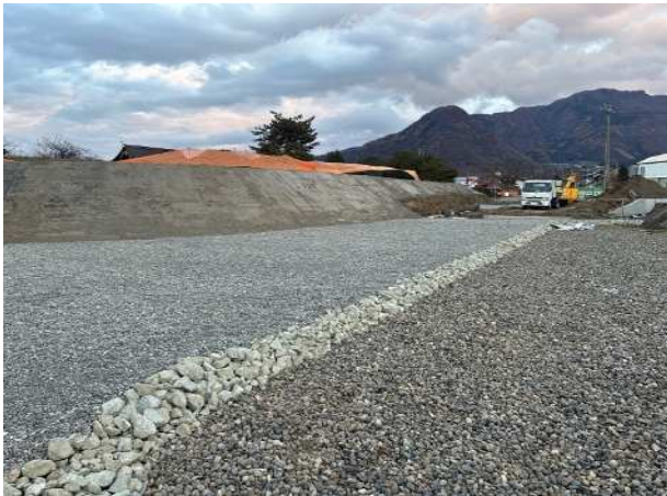
二の丸遺構外保存整備工事
