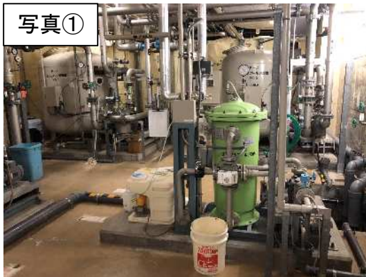
ろ過設備 全面更新 (地下機械室)
