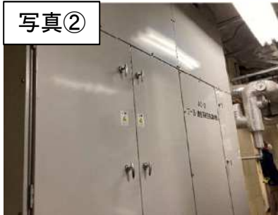
空調設備(AHU)更新
