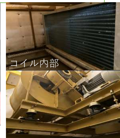
写真③ 空調設備：エアハンドリングユニット
