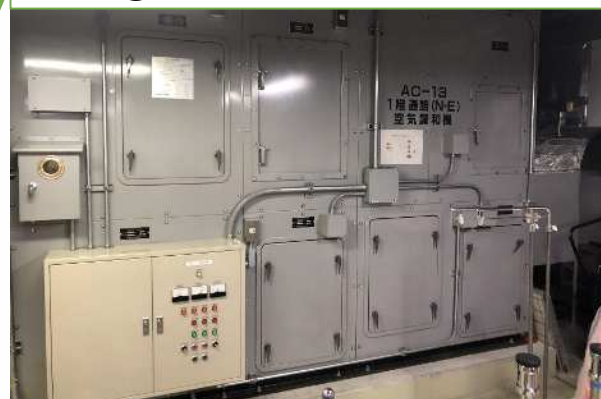
写真③ 空調設備：エアハンドリングユニット
