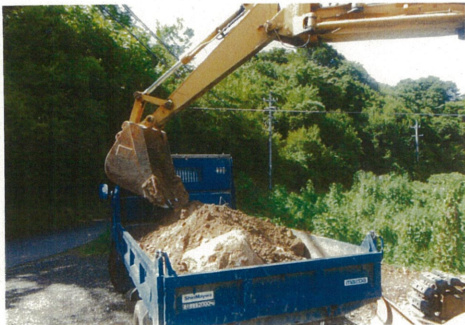
土砂積込状況
