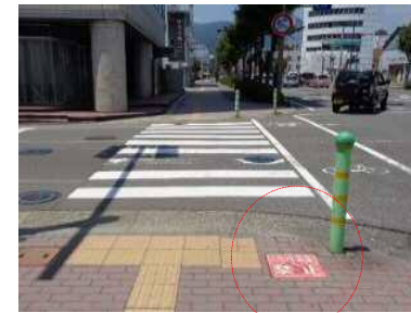
◎ 路面表示シート
