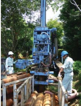
ボアホール掘削作業
