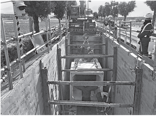
現在も市内各所で進められている雨水幹線整備工事
