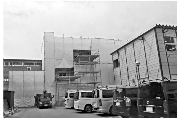
長寿命化改修工事中の裾花小学校
