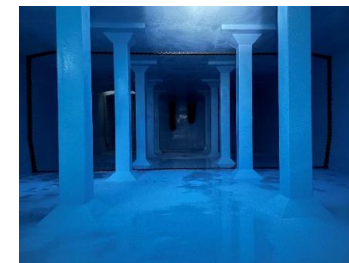
配水池耐震化
