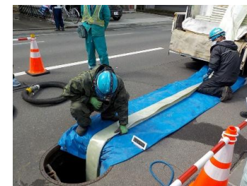
下水道管更生工事
