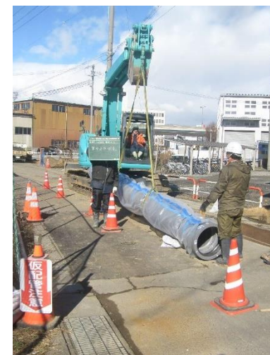
水道管の更新
