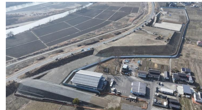
長沼地区河川防災ステーション
