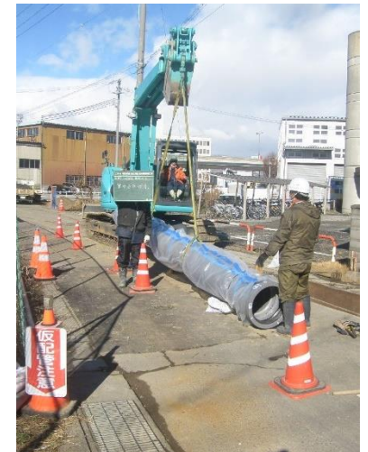
水道管の更新
