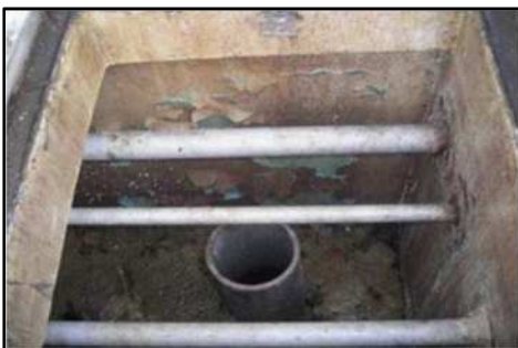
処理槽防食塗装 (処理場)
