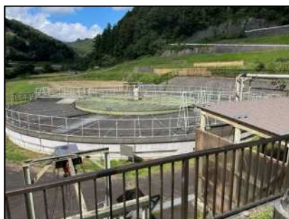
終沈汚泥掻寄機 POD槽
