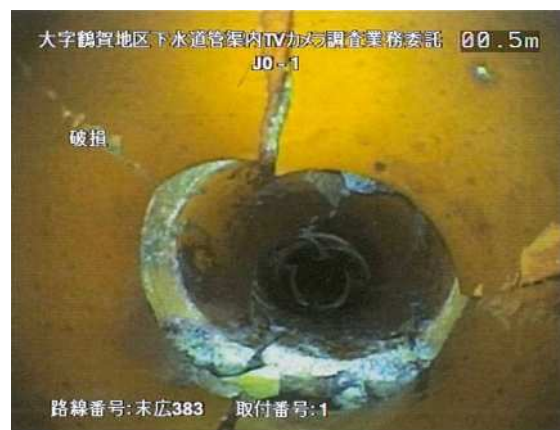
陶管製取付管の破損・扁平事例
