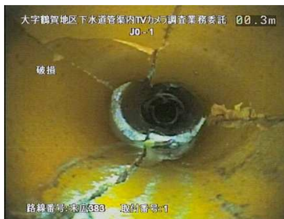
陶管製取付管の破損・扁平事例
