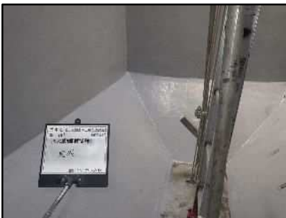
処理槽防食塗装 (処理場)
